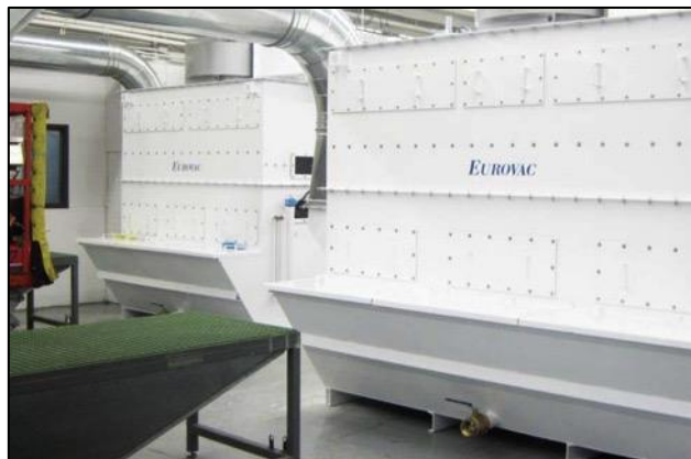
Dépoussiéreur humide central de type "A" – Entretien par raclage des boues
