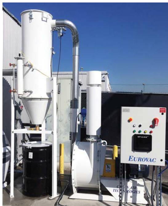
Dépoussiéreur humide central de type "B" – Entretien par valve de drainage
